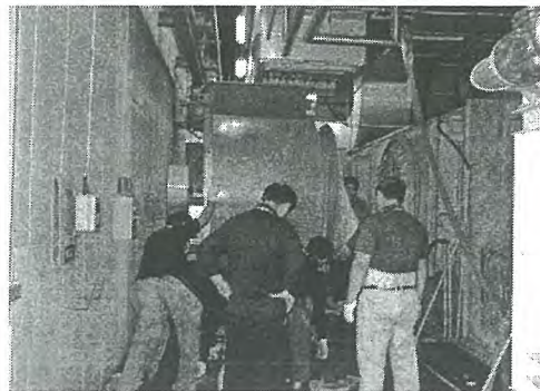
Fig. 3. Installation of new fan
